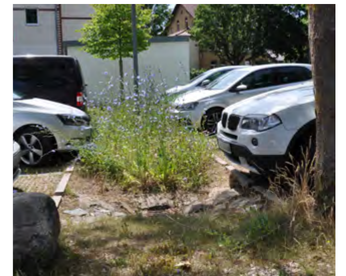
Abbildung 38: Muldenversickerung auf einem Parkplatz (© GEB)
