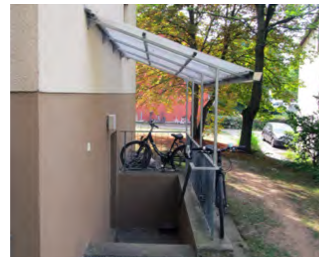
Abbildung 26: Überdachter Kellerabgang. (© GEB)
