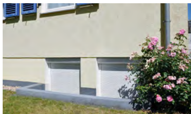
Abbildung 24: Aufkantungungen an Kellerfenstern. (© GEB)
